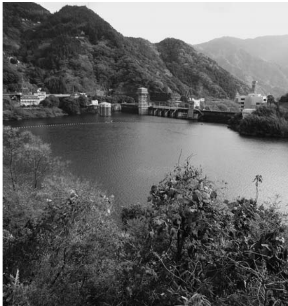
大渡ダムと貯水状況
