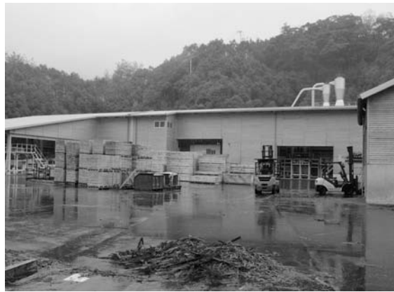
池川木材工業（第四工場）
