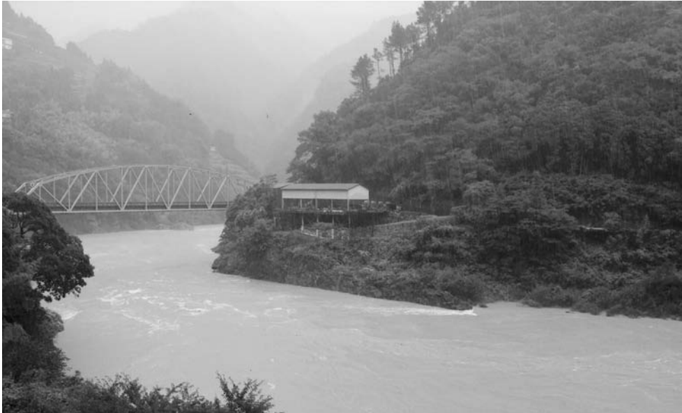
豪雨により国道は通行止め。水位は上昇（寺村付近）
