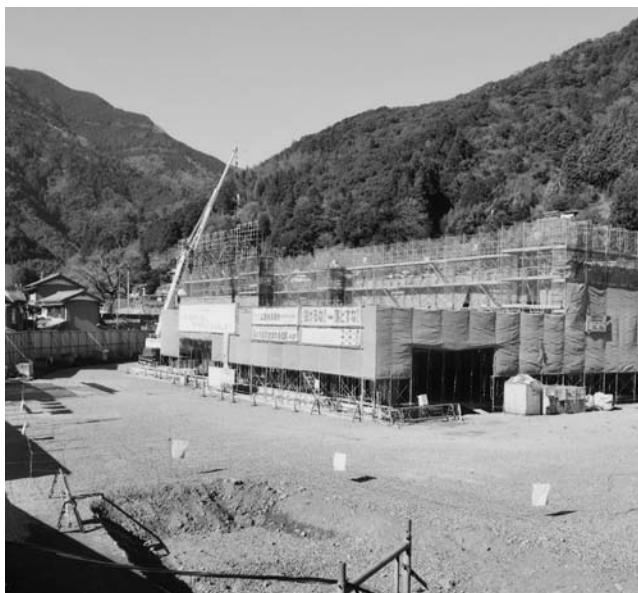
新庁舎建設（平成28年12月27日現在）
