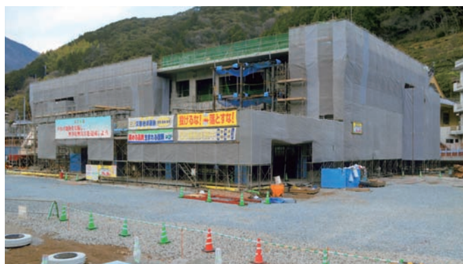
本庁舎新築工事の状況（4月2日現在）
