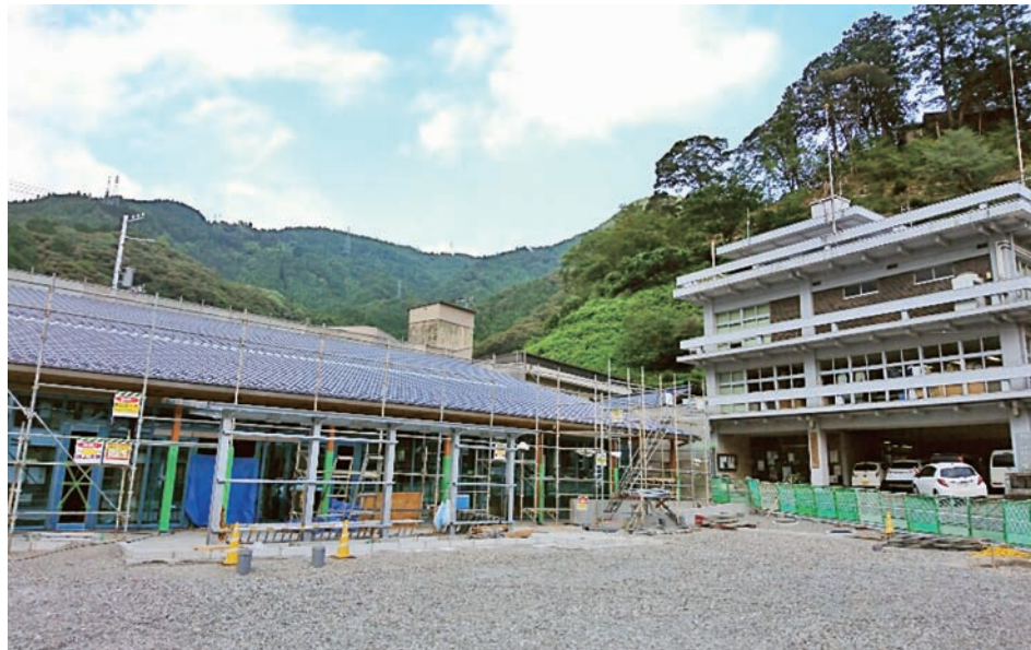
仁淀総合支所新築工事の状況（7月21日現在）右は、現仁淀総合支所
