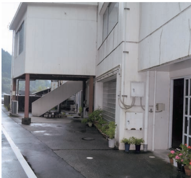
外灯が設置されていない中央公民館駐車場
