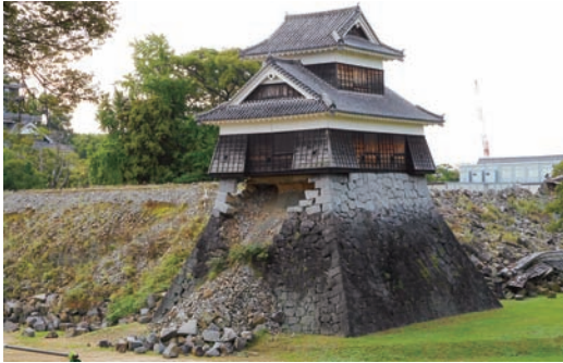
石垣が崩落した櫓（熊本城）
