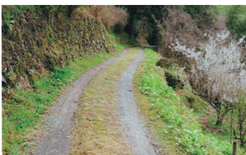
中村地区の未舗装町道
