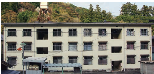
川口町営住宅
