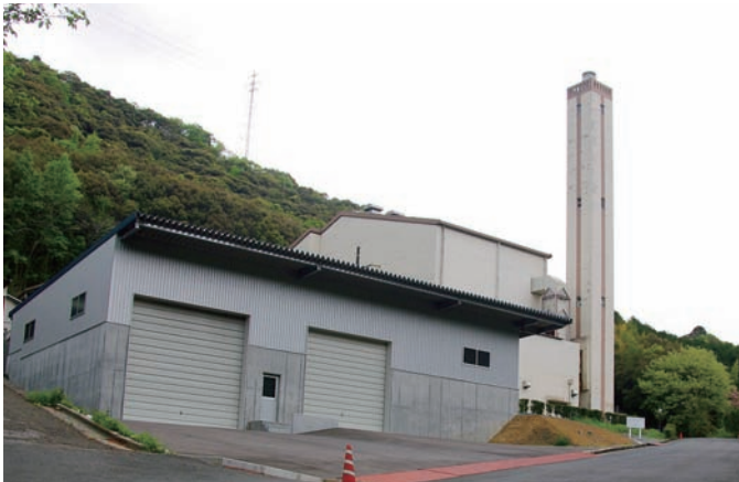
大規模改修される清掃センター
