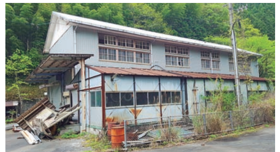
西谷口の内職センター
