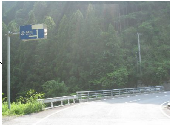
2車線の大規模林道から1車線の道路に入ります
